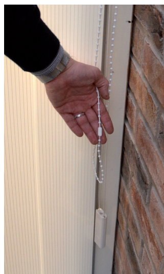
3. Vrid runt lamellerna och se till att kedjelåset inte går över på andra sidan. Om utrymme finns går det bra att korta kedjan nu genom att öppna kedjelåset.
