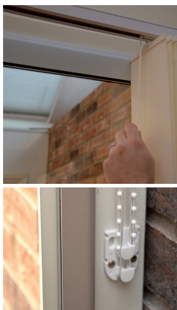
6. Dra in alla lameller så att de är i stängt läge. Dra sedan ut knuten framför den första lamellen tills linan är riktigt spänd i det understa läget, såsom i nedre bilden.
