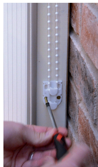
4. Skruva fast säkerhetsanordning med kedjan i det översta läget. Se till att kedjan är ordentligt spänd.
