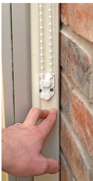
5. Fjern tyngden fra snoren. Legg snoren i nederste stilling.
