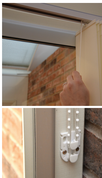
6. Dra inn alle lamellene så de er i lukket stilling. Dra deretter ut knuten før den første lamellen til snoren er skikkelig stramt i underste stilling, som vist i det nederste bildet.
